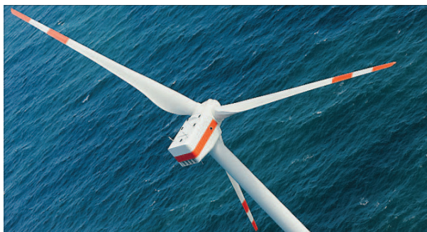
Eine von 80 Anlagen, die im nun offiziell eröffneten größten Offshore-Park Bard Strom liefern. Foto: dpa
